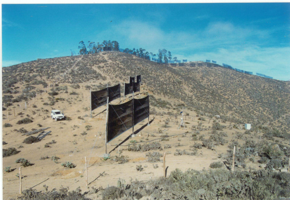
FOTO N°4 : Visión general del conjunto de captadores instalados en el Cerro El Tofo. Constituido por 12 captadores simples de 42 m 2 . cada uno y 19 captadores de 96 m 2 . cada uno, con una su perficie total de 2400 m 2 . Producción diaria promedio: 12000 litros.
