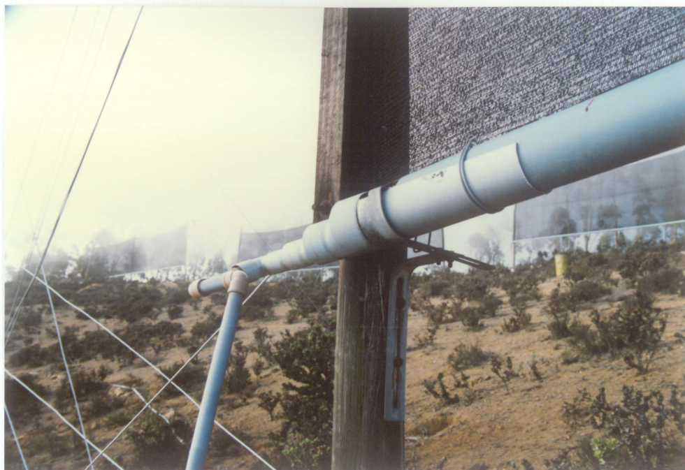
FOTO N°3 : Detalle de la canaleta receptora y su conexión a la tubería conductora.
