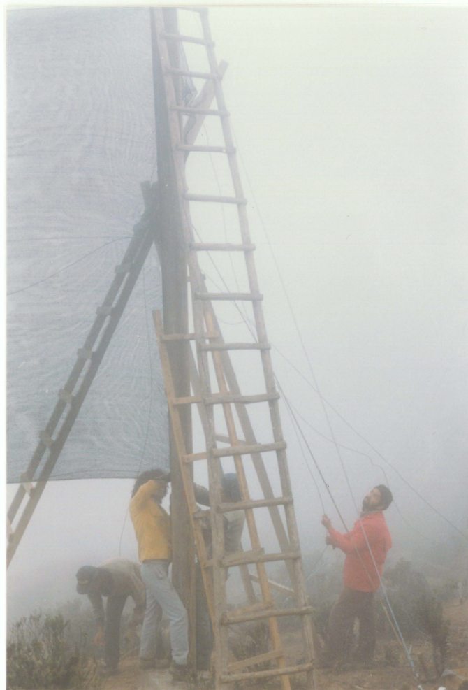
FOTO Nº1 : Etapa inicial de las obras en el Cerro El Tofo. Preparación del hormigón para la instalación de postes y anclajes.
