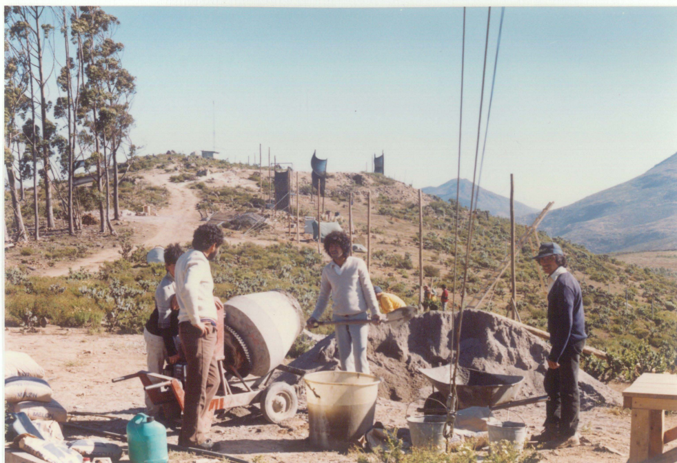
FOTO Nº1 : Etapa inicial de las obras en el Cerro El Tofo. Preparación del hormigón para la instalación de postes y anclajes.
