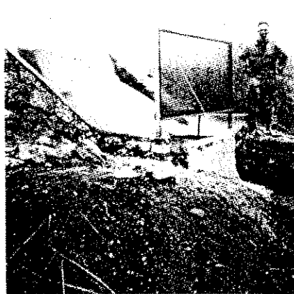
Fig. 5 — Tela instalada no Campo das Fontes (Brava) com a superfície impermeável para captação da água arrastada pelo vento
