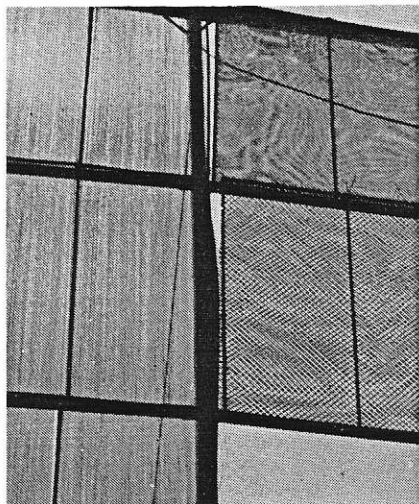
Captador rectangular con un área útil de captación de 90mts 2 , muestra la distribución de las secciones y el tipo de superficies de captación. El Tofo, La Serena, Chile.
